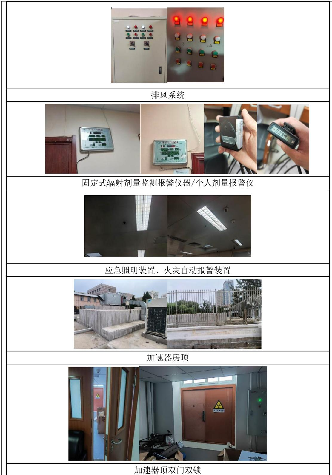
图 3-2 加速器机房配备的相关防护措施现场照片
